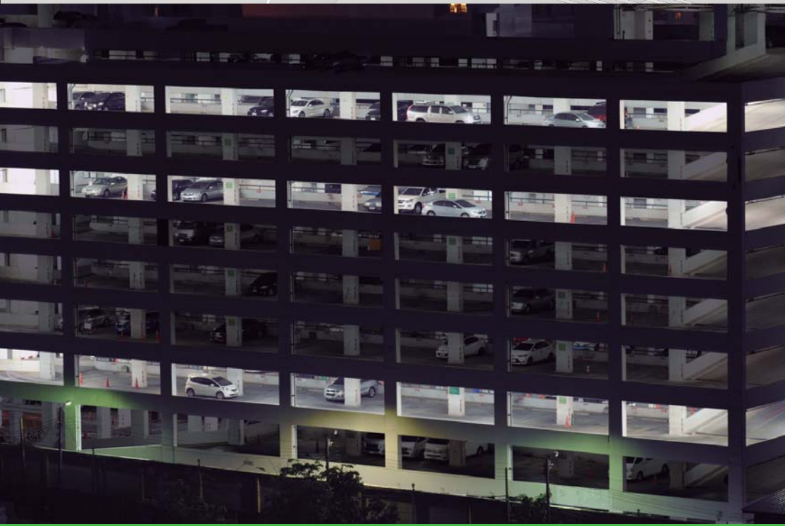
Las plantas con actividad están al 100% de potencia mientras en las que no hay movimiento, quedan al 20%.
