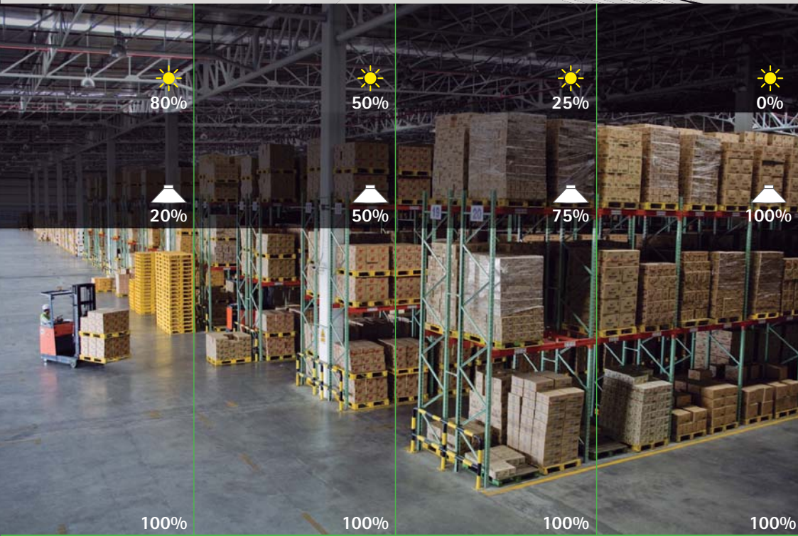
Ejemplo: Campana PHC1456NRS, empresa con lucernarios, día soleado, gran aportación de luz natural, consumo de campana = 30w / 3000Lm. A medida que va oscureciendo, la potencia y luminosidad van subiendo hasta alcanzar los 145w / 15000Lm.
